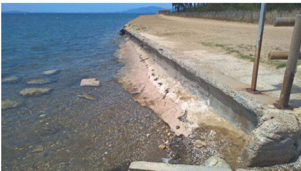
Figure 14 : Photographie montrant l'ouvrage en dur définissant le trait de côte
